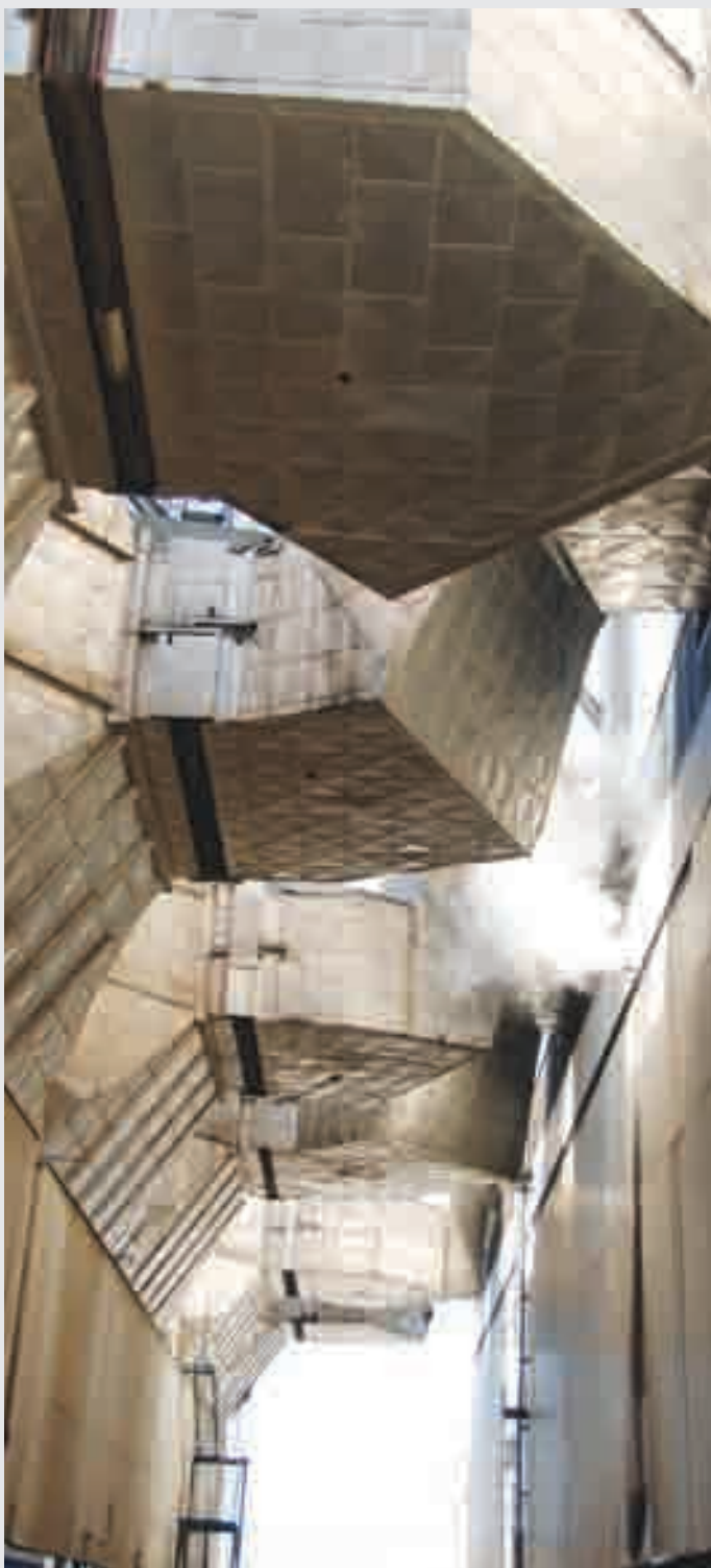
TENT B ELEKTROFILTER
