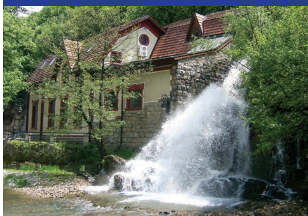
HIDROELEKTRANA „POD GRADOM“ U UŽICU
